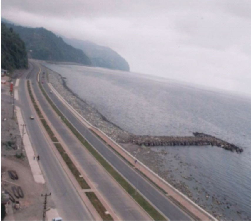
Şekil 14. Hopa-Arhavi arasında yapımı devam eden yoldan bir görünüm
